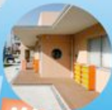
リノベイトされた有明駅ビル （リノベイト）
